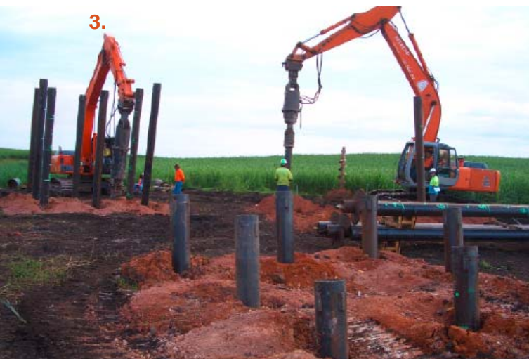
Fot. 3. Fundament pod słup energetyczny
